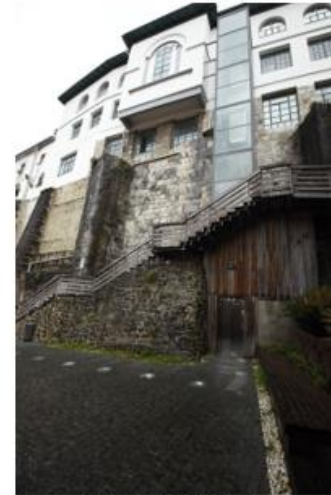
Fachada Este (fachada elevada)
